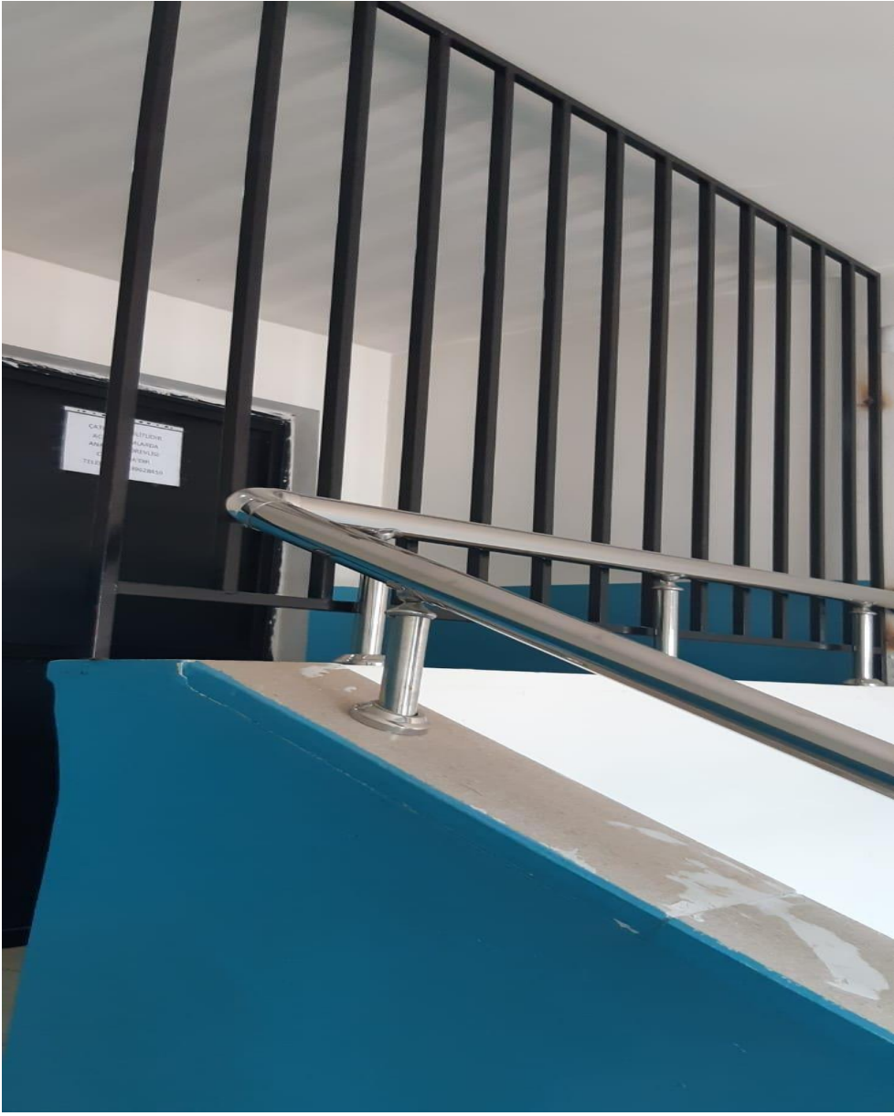
MERDİVEN BOŞLUĞU GÜVENLİK ÇALIŞMASI
